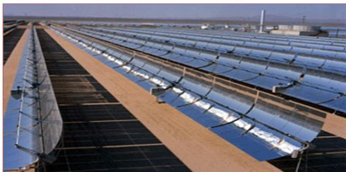
الشكل (2-64) نظام لواقط شمسي على شكل قطع مكافئ
